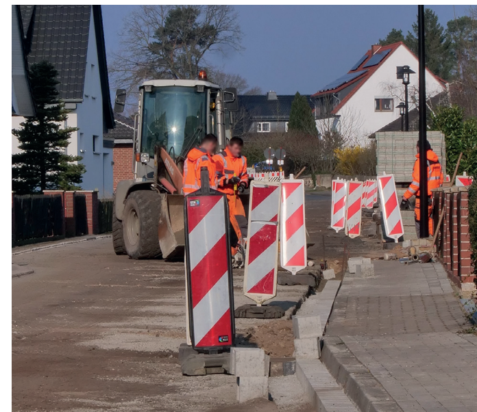
Sanierungsmaßnahmen in der Straße am Brande
