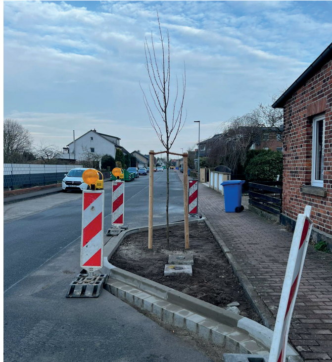
Vorbereitungen für die Baumscheiben in der Poststraße
